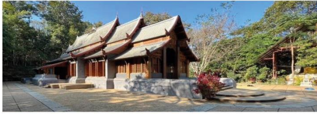
รูปแบบ : หลังคาด้านหน้า 3 ชั้น ด้านหลัง 2 ชั้น และลานทรายโดยรอบ รูปถ่าย : โครงสร้างหลังคาเหล็ก ออกแบบให้มีลักษณะสอดคล้องกับ โครงสร้างไม้ดั้งเดิม รูปถ่าย : ทางวิ่งแกะสลักไม้ ภาพถ่ายโดย คณิศ คณิกุล
