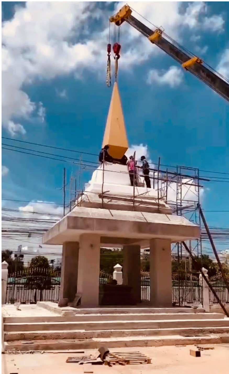
ภาพขณะกำลังก่อสร้าง
