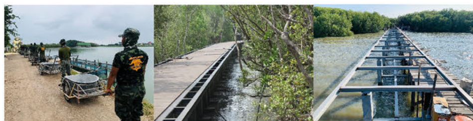
แสดงการถ่ายน้ำหนักด้วยกำลังคน การออกแบบระบบการก่อสร้างที่เป็นเส้นทางตรงและระดับความสูงของทางเดินที่กำหนดแน่นอน
