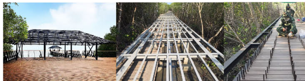
การเลือกใช้วัสดุก่อสร้างเหล็กโครงสร้างรีดร้อนและวัสดุพลาสติกคอมโพสิต (WPC) ปูพื้น ทำให้งานก่อสร้างมีความรวดเร็วและถูกต้องแม่นยำ
