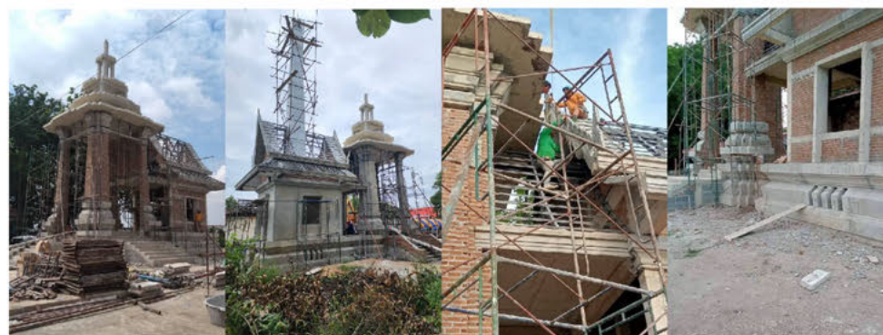
ภาพถ่ายงานก่อสร้างเมรุวัดทะเลว่งวัดในปัจจุบันซึ่งโครงสร้างแล้วเสร็จ
