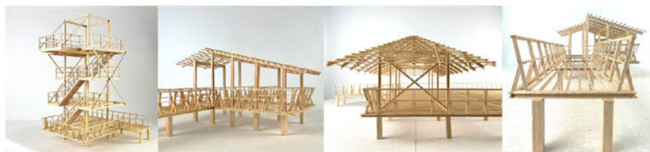
ทุ่นจำลองโครงสร้างของอาคาร 2 อาคารหลังที่ 2 อาคารหลังที่ 4 และอาคารหลังที่ 1 ออกแบบโดยใช้ระบบพิมพ์กดและใช้รูปทรงที่เป็นพื้นฐานแต่ดูเรียบง่าย
